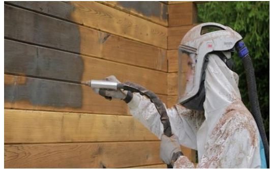
Figure 1 : Nettoyage d'une surface par aérogommage
