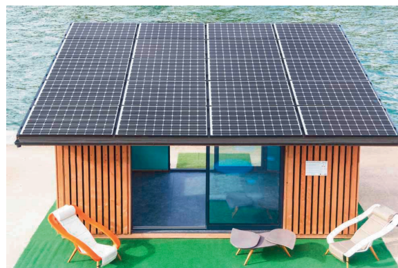
Figure 1. Panneaux photovoltaïques sur un toit plat
