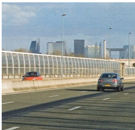
Murs antibruit en polychlorure de vinyle (PVC).
