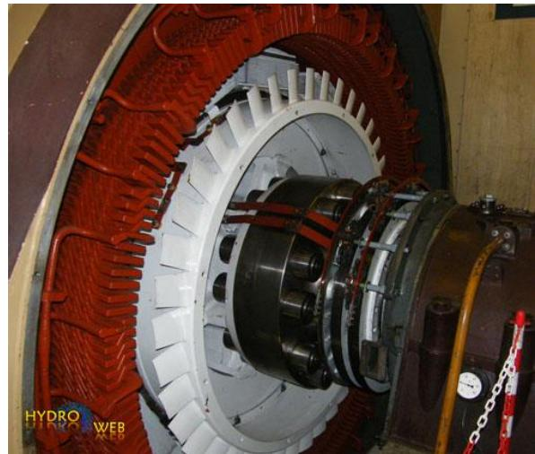
La rotation de l'aimant à proximité du stator correspond à une conversion d'énergie mécanique en énergie électrique.
