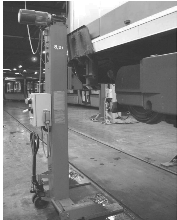
Photo 4 : Colonne d'extrémité en phase de levage
