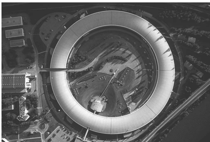
Figure 1 : Vue aérienne du synchrotron de Grenoble
