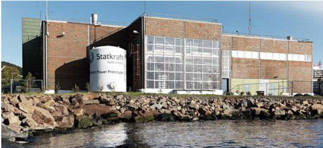
Figure 3 : Centrale osmotique de Tofte © Statkraft
