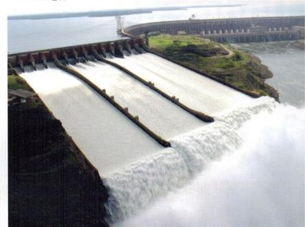
6. Ressaut hydraulique en bas d'un déversoir à proximité du barrage d'Itaipu (frontière Brésil-Paraguay). L'eau s'écoule très rapidement sur le plan incliné avant que l'épaisseur de la couche liquide n'augmente brusquement. Cette transition est ici déclenchée par une légère remontée du plan incliné.
